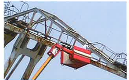
避雷針交換作業 半径30m 50Tラフター
