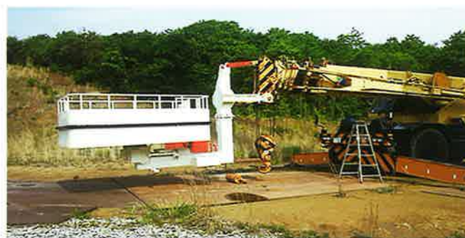
SS-300 50Tラフター取付
